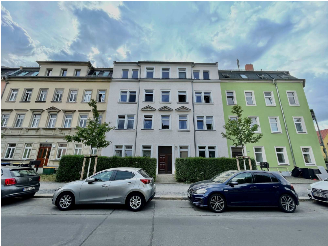
Das Gebäude stammt aus dem Stil anfang des letzten Jahrhunderts
