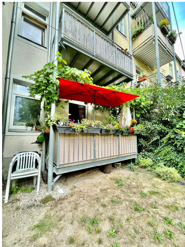
Der Balkon von außen
